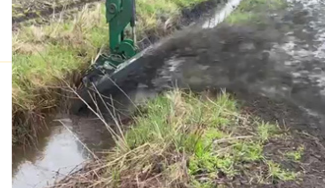
▲ CURAGE DE FOSSÉS À HAUTE PRESSION
